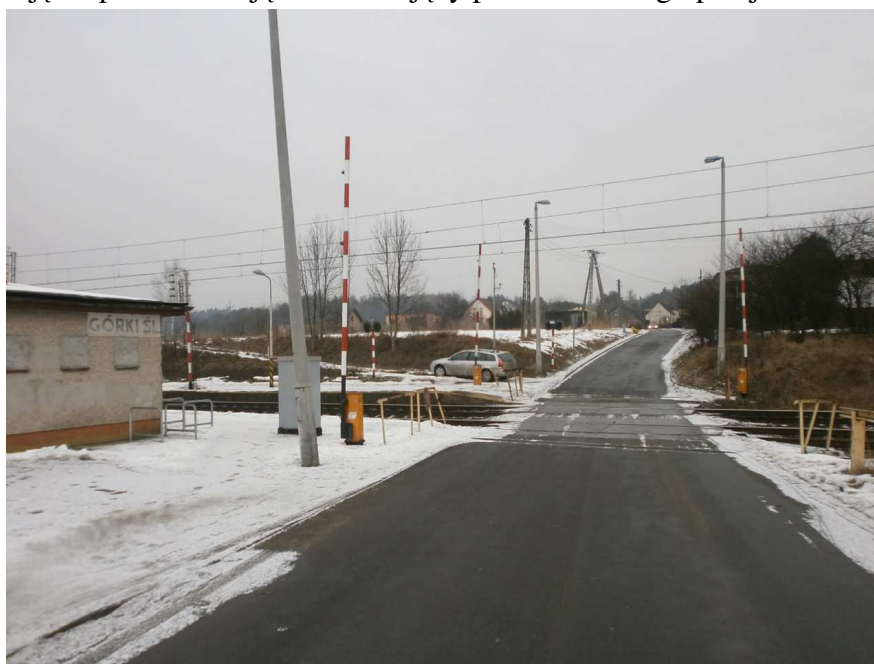
Fot.1 Widok przejazdu od strony ulicy Ofiar Oświęcimskich.
