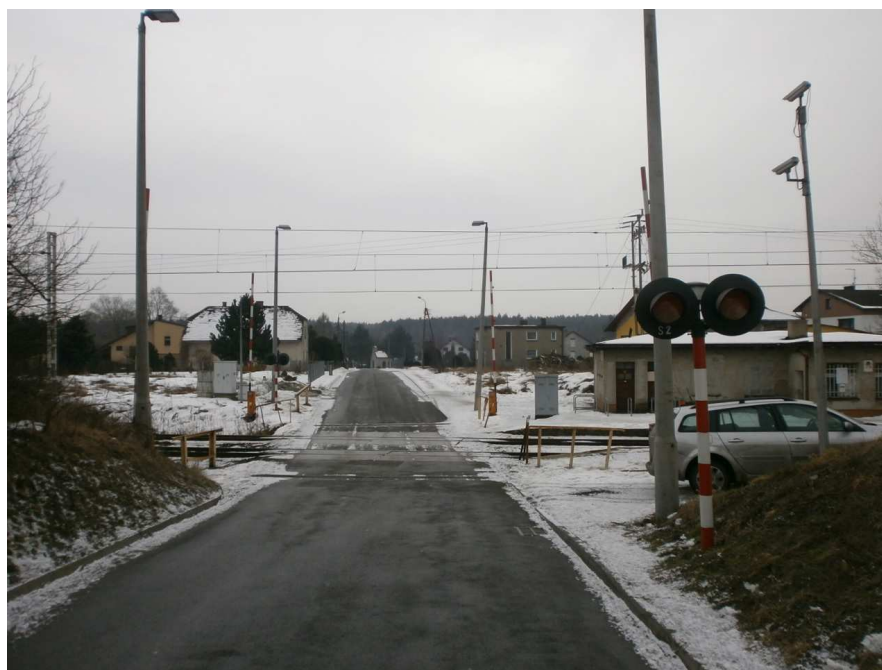
Fot.2 Widok przejazdu od strony ulicy Leśnej.
