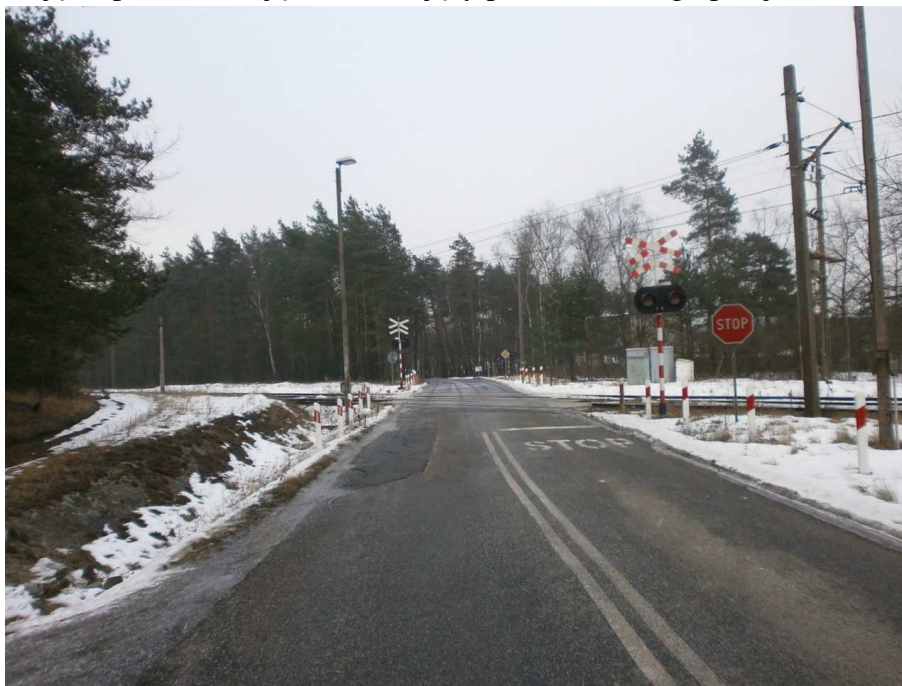
Fot.1 Widok przejazdu od strony DW 919
