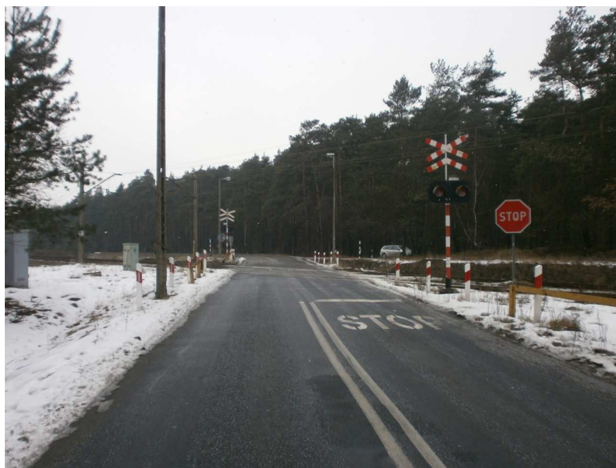
Fot.2 Widok przejazdu od strony miejscowości Górki Śląskie
